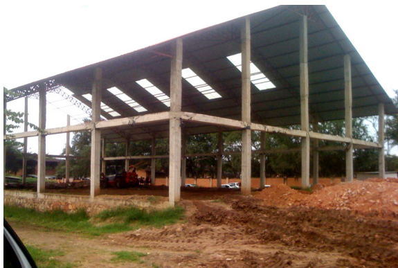
Construction du dojo national
