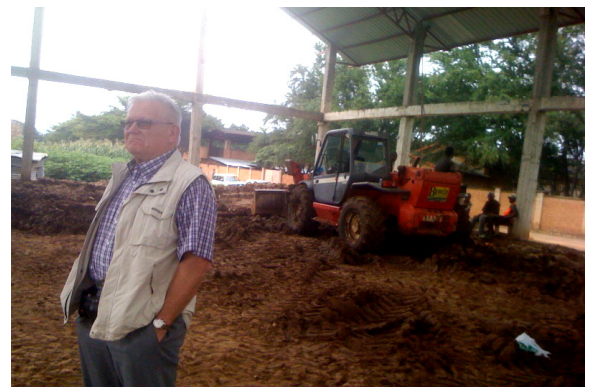
Aménagement du sol
